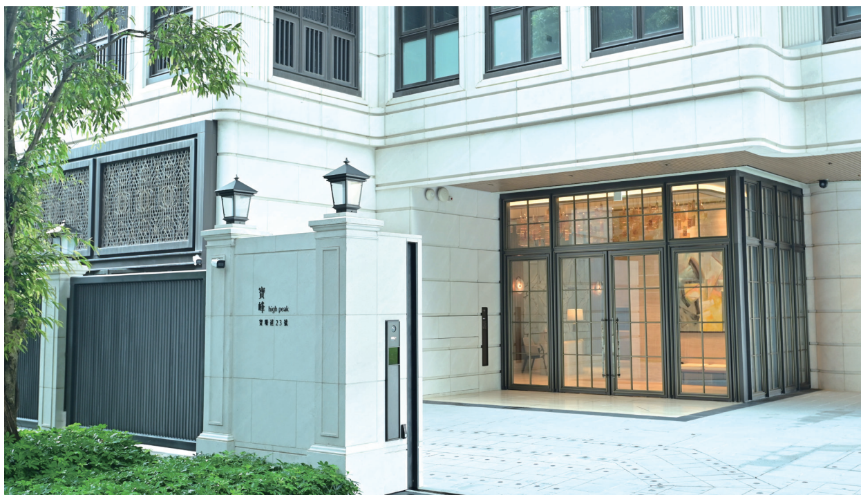
位於寶珊道的「寶峰」住宅發展項目
