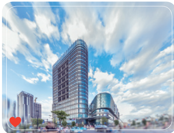
HKR International Centre, Hangzhou 杭州市香港興業國際中心
