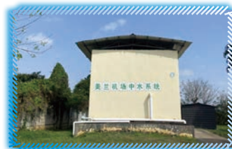
Reclaimed water reuse system 中水回用系統
